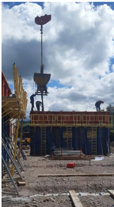
Coulage d'un mur
