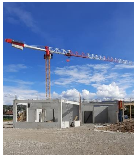
Côté cuisine avec la grue
